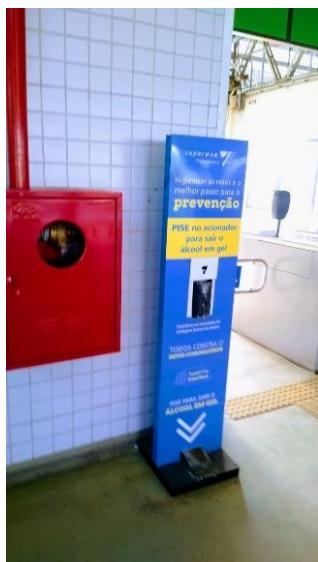
Figura 5.35 SuperVia – Estação Deodoro – 26/05/2021
