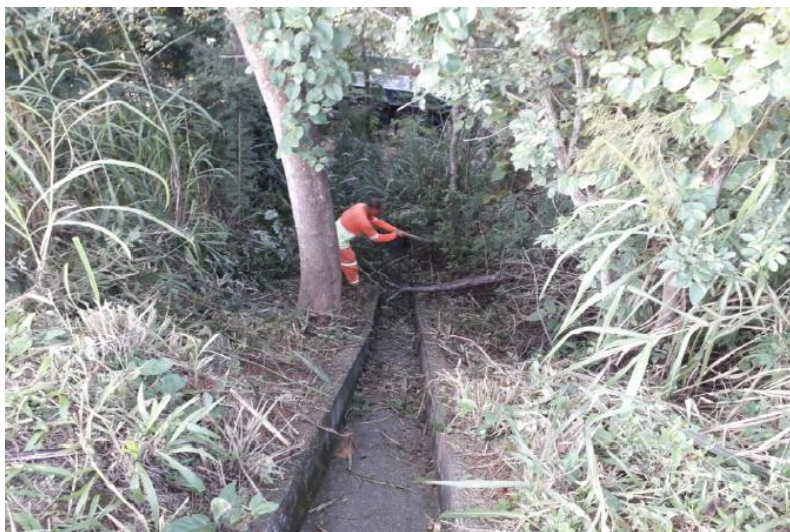
Figura 6.5 ViaLagos – Limpeza de descida d'água – Km 01+600 Norte
