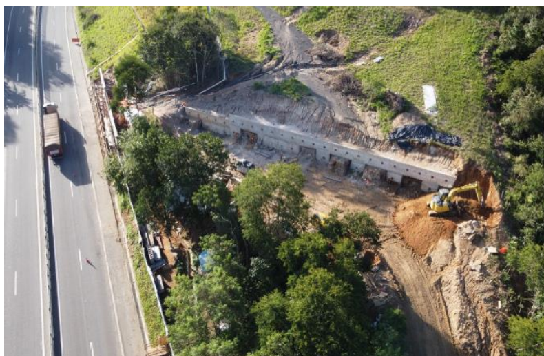
Figura 6.3 ViaLagos – Obra de recuperação de talude – Km 15+700 Sul [2]
