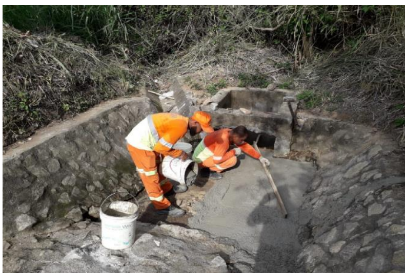
Figura 6.7 ViaLagos – Reparo da caixa coletora – Km 18+900 Norte
