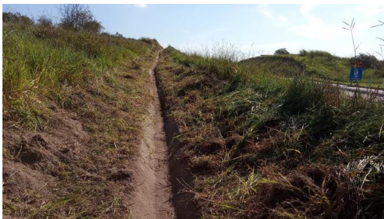
Figura 6.6 ViaLagos – Limpeza de valeta de corte – Km 47+300 Norte
