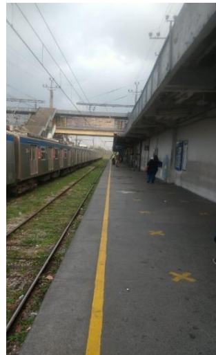
Figura 5.14 SuperVia – Estação Campo Grande – 07/05/2021
