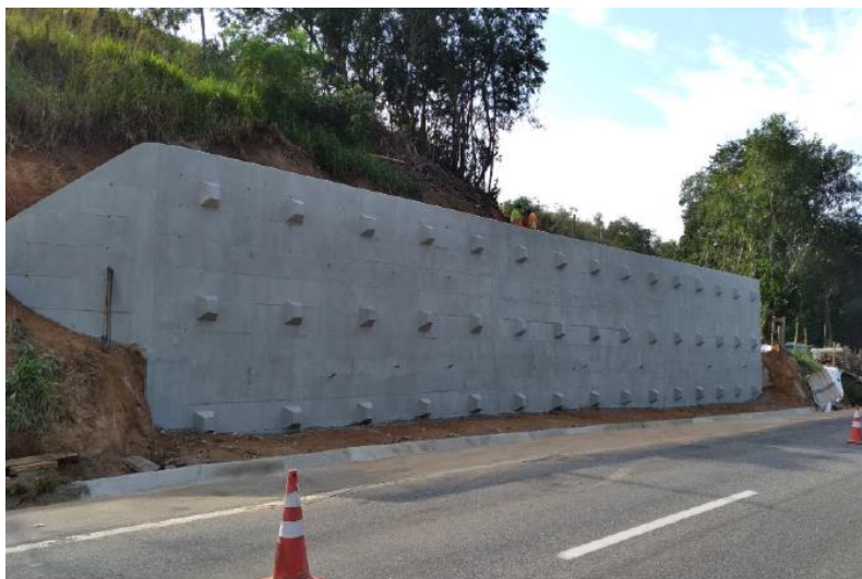
Figura 6.2 ViaLagos – Obra de recuperação de talude – Km 15+700 Sul
