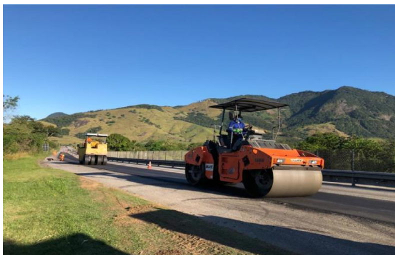
Figura 6.4 ViaLagos – Recuperação do pavimento – Km 16+000 Sul
